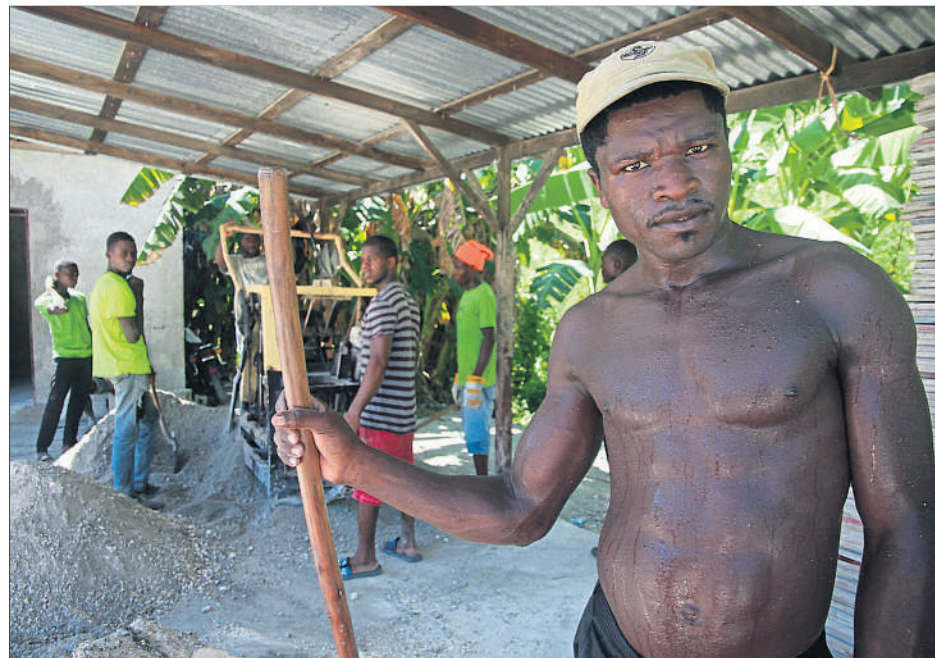
Fabien Legype (vorne) stellt in der haitianischen Stadt Petit-Goâve Steine für den hurrikan- und erdbebensicheren Wiederaufbau her. Die Stadt wurde vom Erdbeben 2010 und Hurrikan Matthew 2016 schwer verwüstet.
